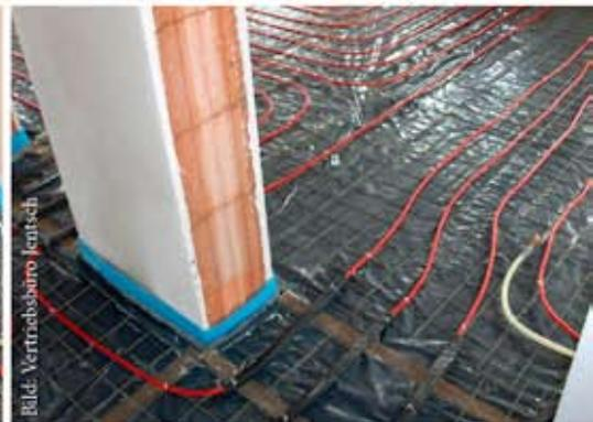
Im Bereich der Türschwellen werden die Kupferrohre mit Isolierung in den Estrich eingegossen
