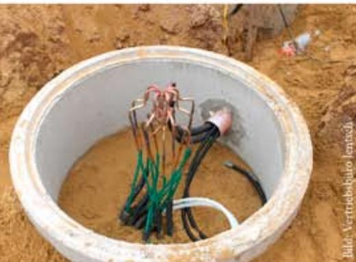
Schacht, in dem alle Kollektorkreise an einem Verteiler und Sammler zusammengeführt werden
