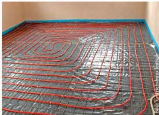
Der Kondensator der Wärmepumpe. Gut zu erkennen auch das Verlegesystem für die Rohre
