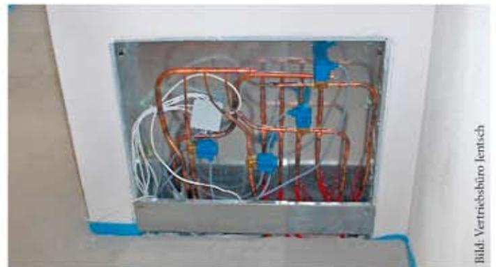
Ein Stockwerksverteiler mit Magnetventilen zur Steuerung der einzelnen Räume
