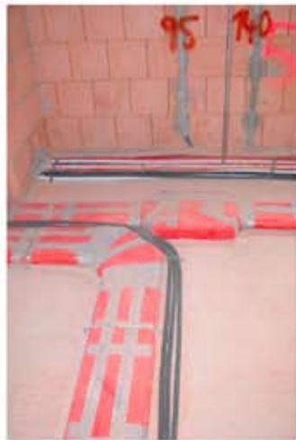
Die Lüftungskanäle werden im Fußbodenaufbau auf der Rohbetondecke in die Dämmebene eingebracht
